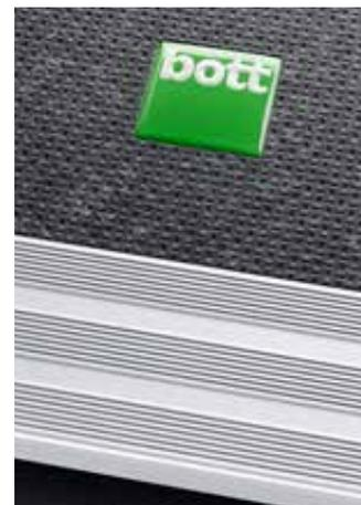
Para que los bordes del suelo bott vario no sufran tanto al efectuar la carga y descarga, reforzamos esas áreas con cantos de aluminio.
